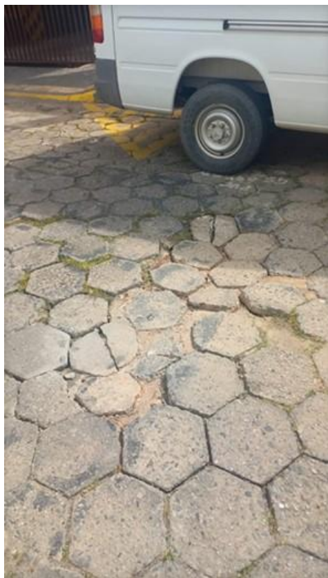
Fotos 2 e 3: Detalhes dos buracos e irregularidades nos bloquetes
