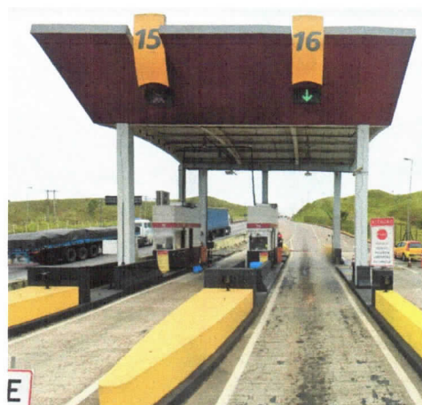
Cabines para a saída de Jacareí
