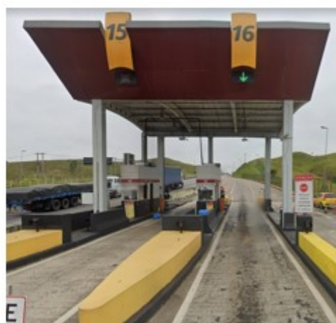
Cabines para a saída de Jacareí
